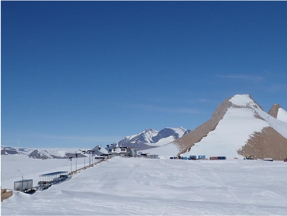
【基地遠景 後方の山「Utsteine/ウートスタイネン」から 一直線に伸びている尾根上の岩盤:リッジ(画像左手)に基地、 アンテナ、風力発電施設が整然と立ち並んでいます。】
